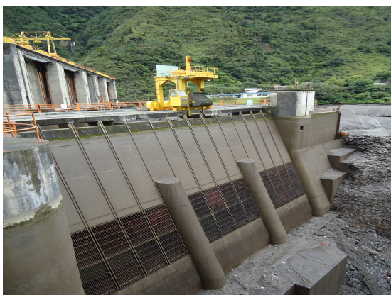
Figura 1. Pórtico Limpia rejillas y Toma de carga de la Central Agoyán (fotografía tomada en un lavado de embalse).
