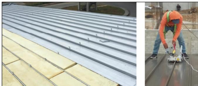
**Figura 6.** Colocación y cosido
