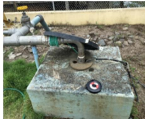
Figura 8. Pozo y bomba sumergible
