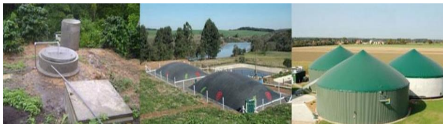
Figura 3. Modelos de biodigestores. De izquierda a derecha se tiene el modelo chino, modelo manga de geomembrana y una planta de biometano
